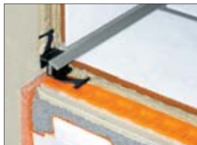
11 Einbau des Randbewegungsfugenprofils Schlüter®-DILEX-EK.
