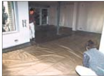
2 Einbau einer Abdecklage bei Verwendung von Fließestrichen.
