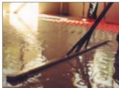
8 Alternativ zu 6 und 7 : Einbringen eines Fließestrichs auf Estrichplatte mit Folienüberzug. Um eine planebene Oberfläche zu erzielen, eignet sich z. B. das Schwabbeln mit einem groben Besen.
