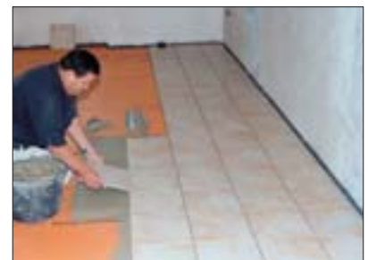
12 Verlegung des Fliesebelags auf Schlüter®-DITRA 25 in Dünnbettmörtel.
