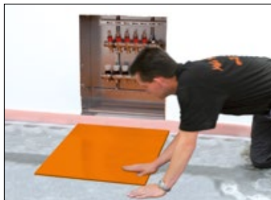
5 Verteilerbereich – Ausgleichsplatte EN FGTS (glatte Folienplatte) einpassen.
