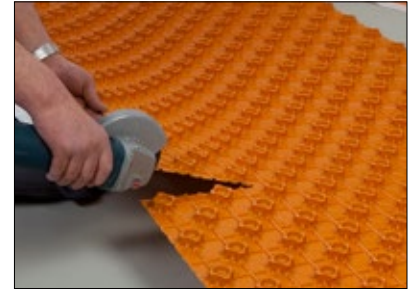
3 Verarbeiten der Estrichnoppenplatte – Zuschneiden mit dem Winkelschleifer.
