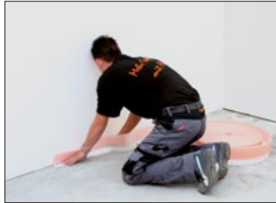
2 Einbau des Randstreifens BRS 808 KSF mit Klebestützfuß.
