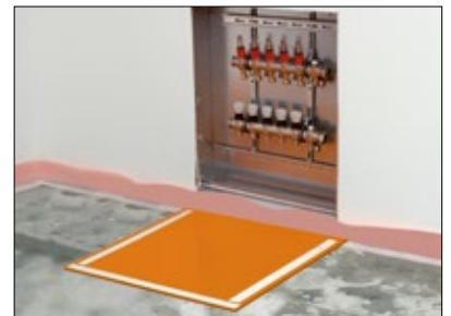
6 Verteilerbereich – beigefügte Doppelklebebänder aufbringen.
