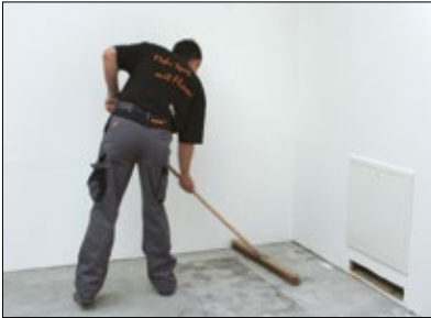
1 Reinigen des ausreichend tragfähigen und ebenflächigen Untergrundes.
